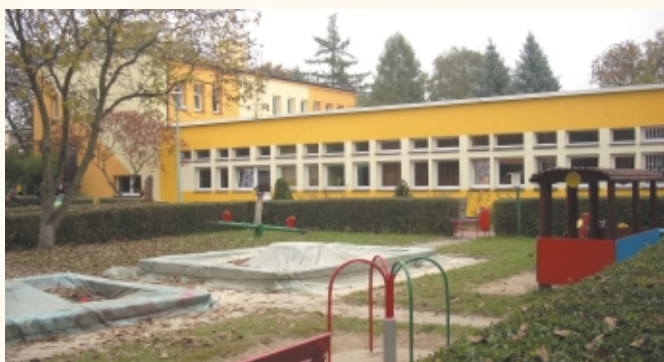
Błonie - Termomodernizacja budynku Przedszkola nr 3 im. J. Brzechwy z oddziałami integracyjnymi ul. Poniatowskiego 12b
