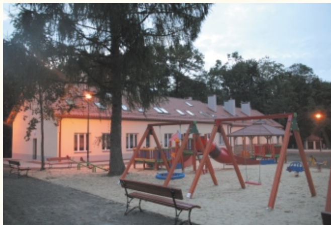
Trzciana, Gmina Świlcza - Adaptacja zabytkowego budynku na Żłobek i Przedszkole Publiczne, Trzciana 193 B
