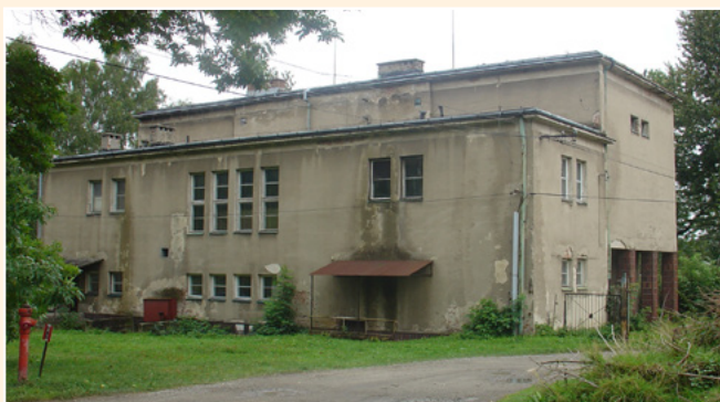
Budynek przed modernizacją
