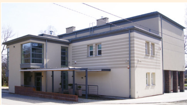
Budynek po modernizacji
