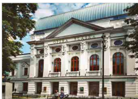
Bytom Wykonanie iluminacji budynku Opary Śląskiej w Bytomiu ul. Moniuszki 21/23
