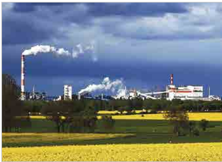
Głogów Modernizacja ciągu technologicznego do wytopu miedzi zabudowanego w KGHM Polska Miedź S.A. w Oddziale Huta Miedzi Głogów, ul. Żukowicka 1
