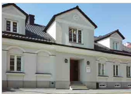
Bielsko-Biała Adaptacja zabytkowego budynku na Przedszkole Terapeutyczne Plac Opatrzności Bożej 14
