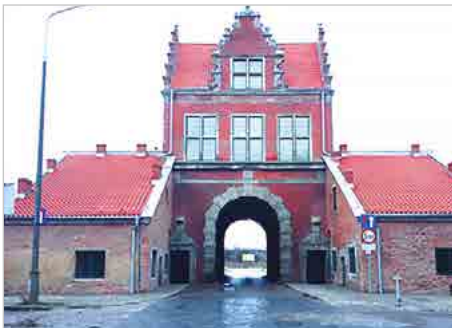
Gdańsk Remont Bramy Nizinej ul. Grodza Kamienna 5
