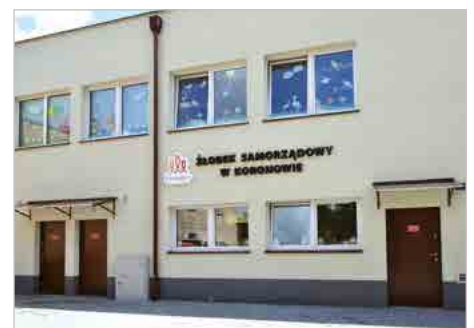
Koronowo Modernizacja i adaptacja budynku gospodarczo-użytkowego na Żłobek Samorządowy
