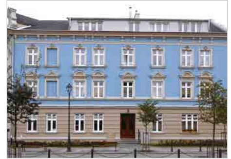
Gdańsk Renowacja elewacji frontowej wraz z projektem docieplenia ścian szczytowych i tylnych oraz robotami towarzyszącymi ul. Wajdeloty 14
