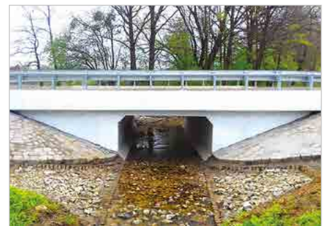
Smogorzów Wielki Przebudowa ceglaneanego przepustu sklepionego w km 3+405 drogi powiatowej nr 1277D na odcinku Smogorzów Wielki – Wińsko
