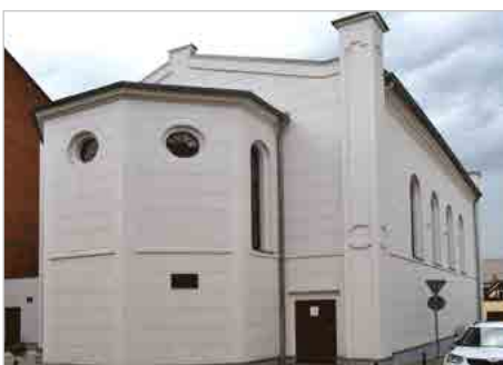
Koronowo Rekonstrukcja i przebudowa budynku Synagogi w Koronowie (prace konserwatorskie i roboty budowlane) wraz z adaptacją na cele kulturalno-oświatowe
