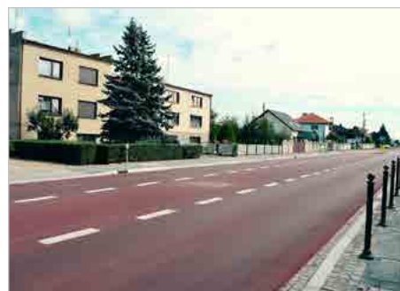
Sulmierzycy Przebudowa Alei Klonowicza w Sulmierzycach w ciągu drogi wojewódzkiej nr 444
