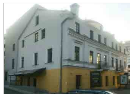
BIAŁORUŚ Mińsk Modernizacja kamienicy przy ulicy Komsomolskiej 6
