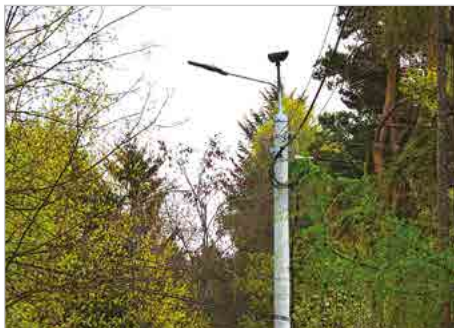
Podkowa Leśna Modernizacja oświetlenia elektrycznego – wymiana 999 sztuk opraw ulicznych
