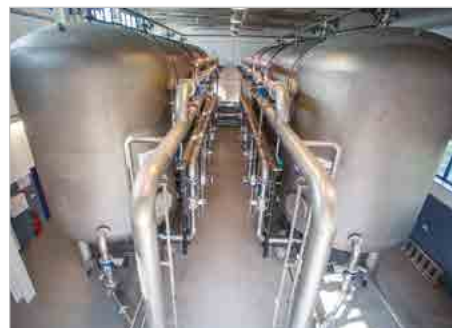
Stary Sącz Stacja uzdatniania wody ul. Podegrodzka
