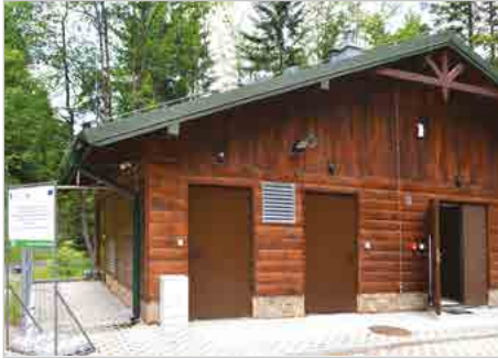
Gaboń/Stary Sącz Stacja uzdatniania wody w miejscowości Gaboń w gminie Stary Sącz
