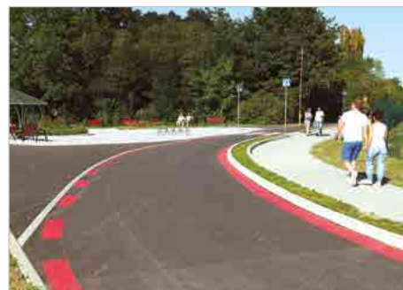
Bielsko-Biała Przebudowa ścieżki rowerowej wokół lotniska
