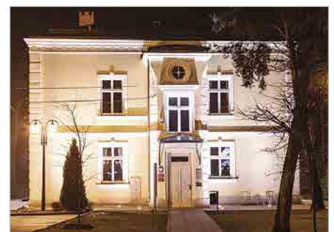
Józefów Remont Elewacji Budynku "B" Urzędu Miasta Józefowa ul. Kard. Wyszyńskiego 1
