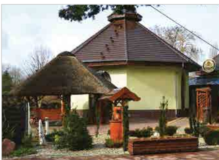
Inowrocław Dobudowanie Sali Kominkowej ul. Przy Stawku 12
