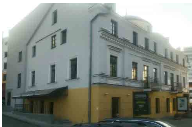
MODERNIZACJA KAMIENICY PRZY ULICY KOMSOMOLSKIEJ 6 W MIŃSKU
