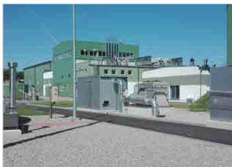
Tarnów Instalacja termicznej hydrolizy i fermentacji osadów ściekowych na terenie oczyszczalni ścieków ul. Czysta 14
