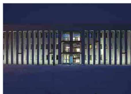
Dąbrowa Górnicza Przebudowa i rozbudowa budynku administracyjnego, u. Powstańców 13
