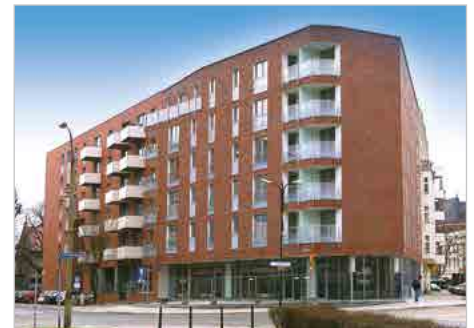
Gliwice Dobudowa i przebudowa budynków mieszkalno-usługowych przy zbiegu ulic Jana Pawła II i Mikołowskiej
