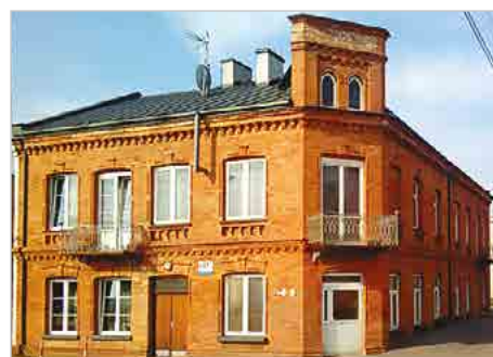
Błonie Remont elewacji oraz wymiana pokrycia dachowego na budynku mieszkalnym wielorodzinnym przy ul. Warszawskiej 37
