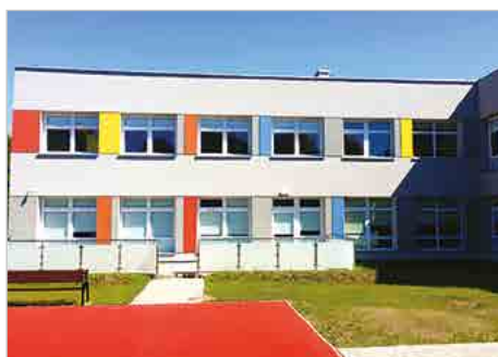
Dąbrowa Górnicza Adaptacja pomieszczeń po Zespole Szkół Specjalnych Nr 5 na potrzeby Żłobka Miejskiego ul. Mireckiego 28
