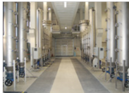
Mokry Dwór Wrocław Przebudowa budynku technologicznego, chemicznego pod budowę Stacji badawczej Na terenie ZPW Mokry Dwór ul. Na Grobli 14-16
