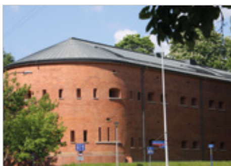
Warszawa Adaptacja obiektów i urzędzeń budowlanych w rejonie kapanierii i baterii barkowej w Cytadeli Warszawskiej wraz otoczeniem na potrzeby Muzeum Katyńskiego, ul. Dymińska 13
