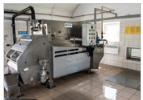
Dębno Budowa kanalizacji sanitarnej i adaptacja oczyszczalni ścieków na terenie Aglomeracji Dębno
