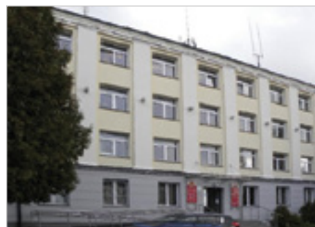
Opole Lubelskie Modernizacja budynku administracyjnego Starostwa Powiatowego, Urzędu Miasta i Prokuratury Rejonowej ul. Lubelska 4
