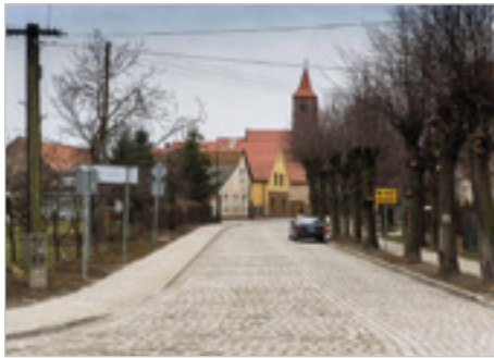
Kaszyce Wielkie - Prusice Modernizacja drogi powiatowej nr 1330D Kaszyce Wielkie - Prusice
