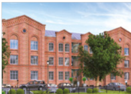
Gdańsk Restauracja kamienicy na Starym Mieście ul. Tobiasza 6, 7, 8
