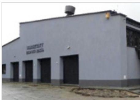
Poniatowa Modernizacja budynku Warsztatów Zespołu Szkół ul. Fabryczna 16c
