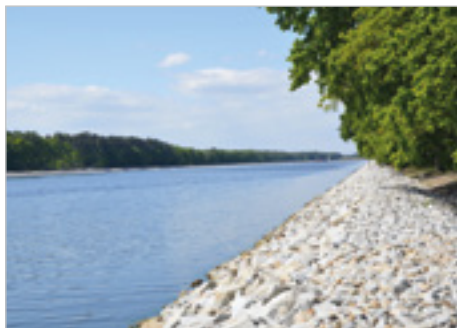
Świnoujście Modernizacja toru wodnego Świnoujście – Szczecin (Kanał Piastowski i Mieliński)
