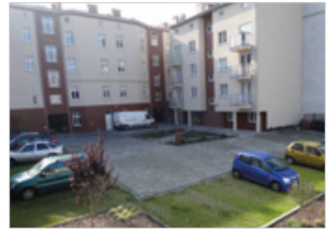
Katowice Remont i przebudowa budynków frontowych wraz z przyłączami kanalizacyjnymi i budowa budynku mieszkalnego oraz zagospodarowanie terenu ul. Wojewódzka 36, 36a, 38
