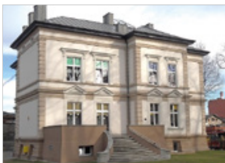
Zabrze Termomodernizacja Przedszkola nr 34 wraz z modernizacją kuchni, ul. Brysza 4
