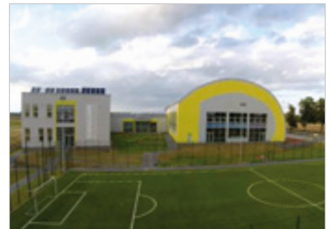
Kosakowo Wybudowanie Zespołu Obiektów Gimnazjum Gminnego wraz z zagospodarowaniem terenu ul. Żeromskiego 11
