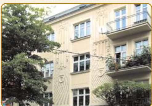
Katowice Renowacja elewacji frontowej budynku ul. Żwirki i Wigury 11
