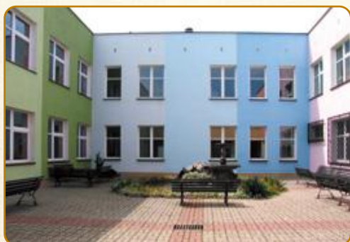
Koło Termomodernizacja Liceum Ogólnokształcącego im. Kazimierza Wielkiego ul. Blizna 37
