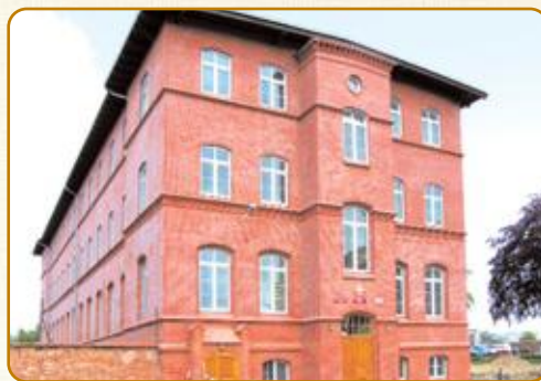
Chojnice Modernizacja budynku Szkoły w Schronisku dla Nieletnich
