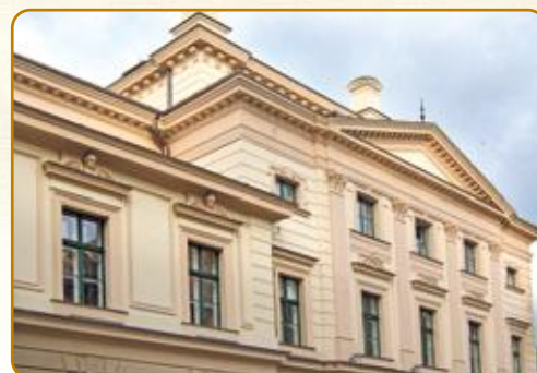
Bielsko-Biała Modernizacja i rewaloryzacja budynku głównego Teatru Polskiego ul. 1 Maja 1
