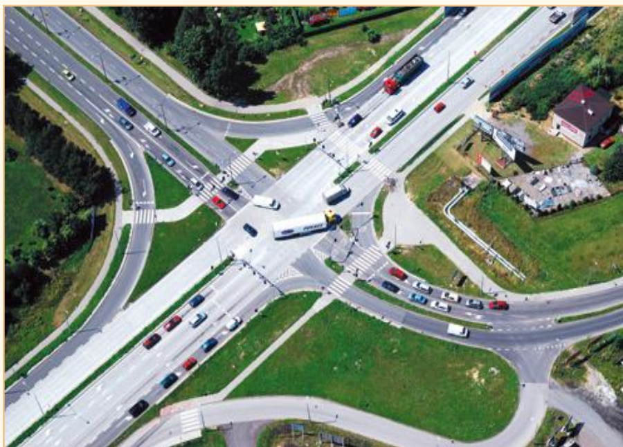
Modernizacja odcinka drogi DK-81 w Żorach
