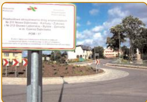
Czarna Dąbrowka Przebudowa skrzyżowania drogi wojewódzkiej nr 211 i 212 na „Małe Rondo”
