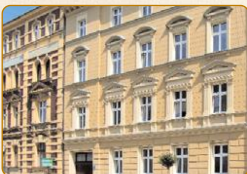
Katowice Modernizacja zabytkowego budynku mieszkalnego ul. Mariacka 28
