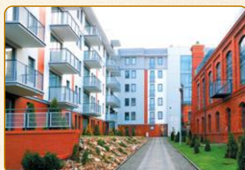
Bydgoszcz Modernizacja i adaptacja pralni garnizonowej na budynek mieszkalny ul. Toruńska 45 B
