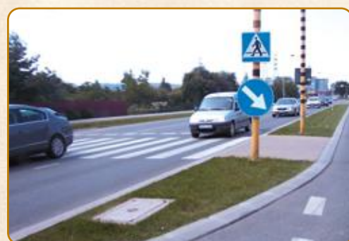
Rzeszów Modernizacja ulicy Sikorskiego
