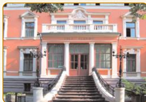
Łódź Renowacja elewacji budynku Urzędu Stanu Cywilnego ul. Pabianicka 2
