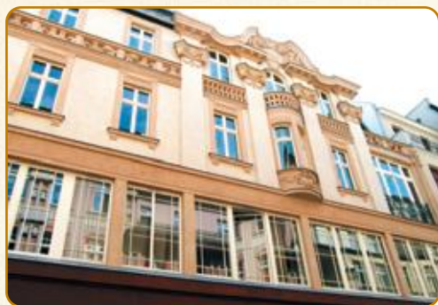
Katowice Restauracja zabytkowej elewacji budynku ul. Dyrekcyjna 9
