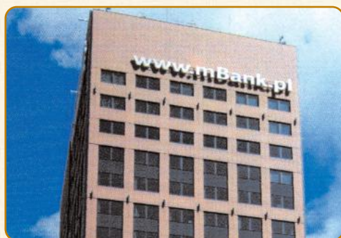
Łódź Modernizacja budynku biurowego Red Tower ul. Piotrkowska 148/150
