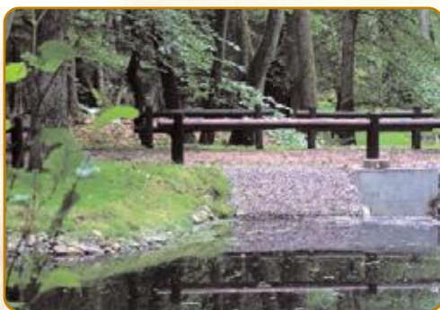
Goleniów Modernizacja zlewni rzeki Świdniana
