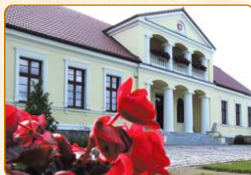
Budziejewo gm. Mieścisko Modernizacja Dworku „Róża Poraja” Budziejewo 1
