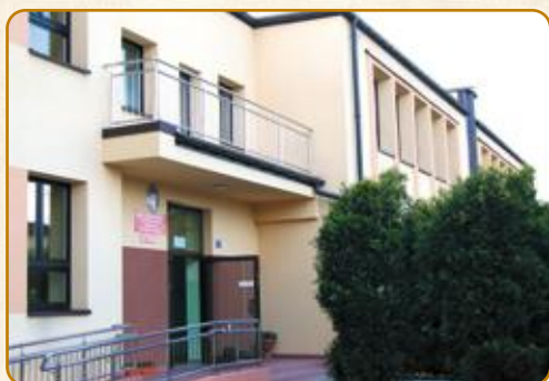
Krzyżowice Modernizacja i rozbudowa Zespołu Szkolno-Przedszkolnego ul. Szkolna 7
