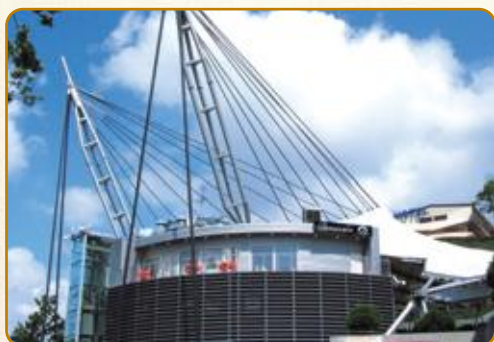
Płock Umocnienie Skarpy Wiślanej na odcinku od Hotelu Starzyńskiego do Katedry wraz z budową Amfiteatru ul. Rybaki
