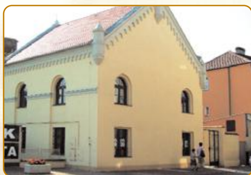
Mosina Renowacja elewacji zabytkowego budynku Izby Muzealnej ul. Niezłomnych 1
