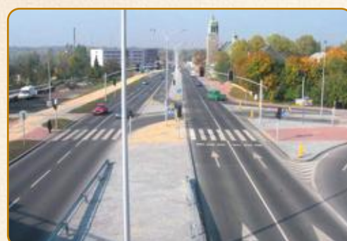
Bytom Modernizacja bytomskiego odcinka Obwodnicy Północnej Aglomeracji Górnośląskiej
