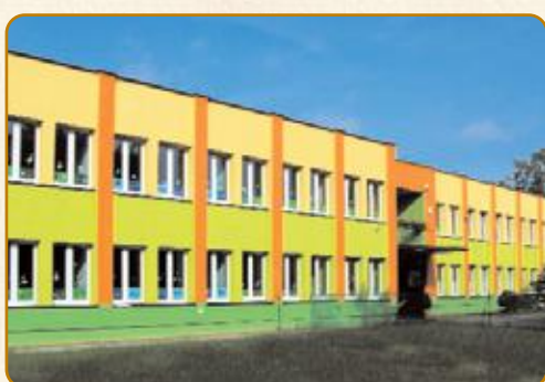
Mysłowice Termomodernizacja budynku Żłobka Miejskiego ul. Reymonta 11
