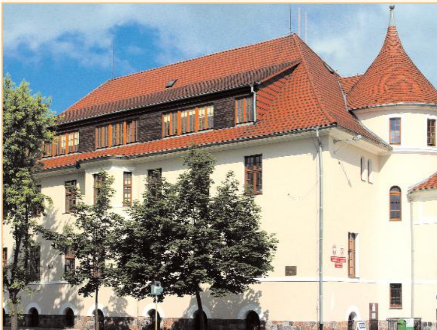
Zwieńczeniem kompleksowej modernizacji zabytkowego budynku Starostwa Powiatowego był remont elewacji
