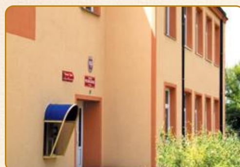
Łęg Probostwo gm. Drobin Modernizacja Szkoły oraz sali gimnastycznej
