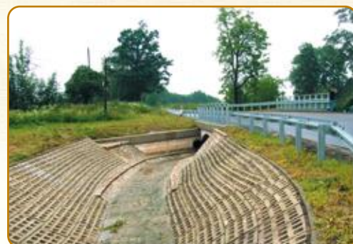
Pobiedna Modernizacja mostu w ciągu drogi wojewódzkiej nr 358
