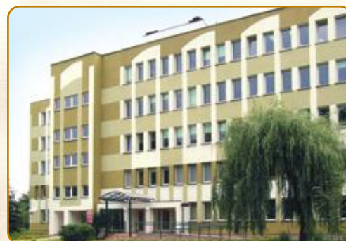
Ksawerów Modernizacja i adaptacja budynku Urzędu Gminy na cele mieszkalne i biurowe ul. Kościuszki 3h
