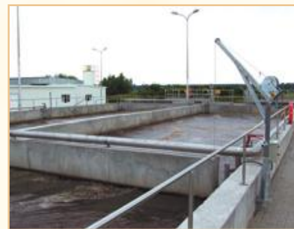
Modernizacja i rozbudowa oczyszczalni ścieków w Wieleniu
