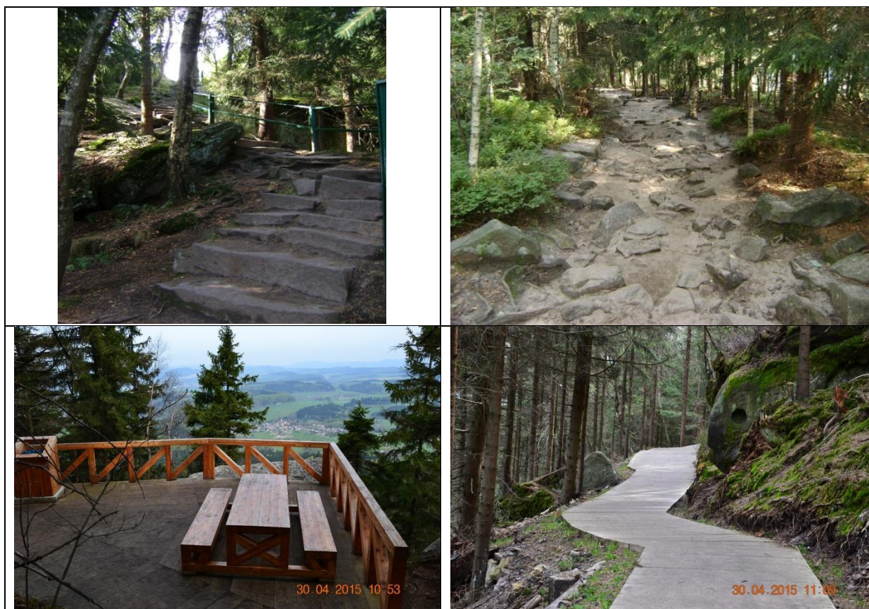
Rys. 6. Infrastruktura turystyczna w Parku Narodowym Gór Stołowych – sposób na udostępnienie terenów rekreacyjnych osobom niepełnosprawnym (górne zdjęcia obrazują tradycyjne ścieżki turystyczne – niedostępne dla osób na wózku, na dolnych zaprezentowano nawierzchnie gładkie – dostosowane do przejazdu na wózku)
