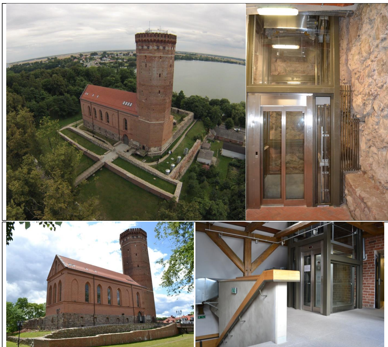
Rys. 4. Zamek w Człuchowie oraz winda zamontowana w baszcie zamkowej
